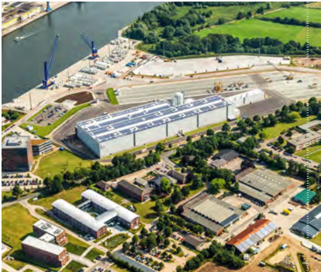
Das neue Produktionswerk für Hybridtürme entstand direkt am Nord-Ostsee-Kanal.
