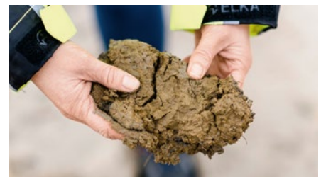
Für den Ausbau des Kais wurden 1,4 Millionen Kubikmeter Boden abgetragen.
