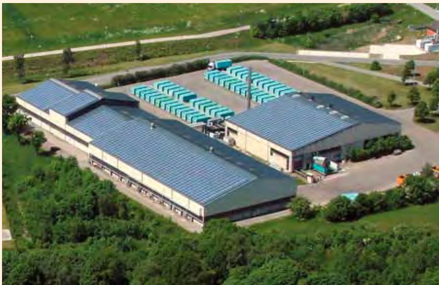
Schafft jährlich rund 330.000 Kilowattstunden: die Photovoltaik-Anlage von BALTICSOLAR für die Stadtwerke Neumünster auf dem Dach der Kompostierungsanlage Wittorferfeld.
